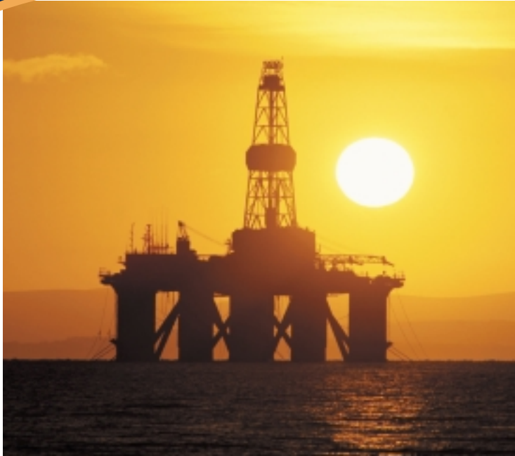
Beispiel einer Anwendung: Offshore Plattform
