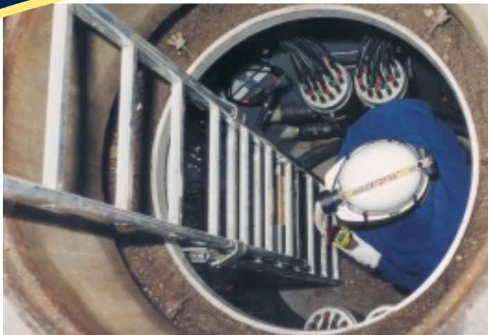
Anwendungsbeispiel : Arbeiten in Kanälen
